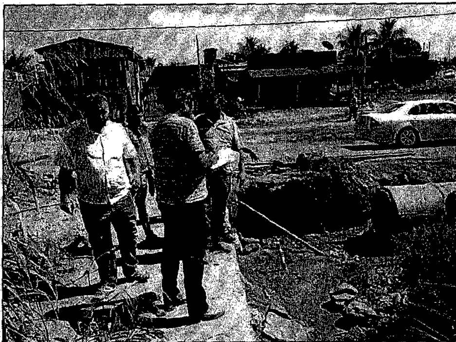
Figura 28 - Obra de drenagem de águas pluviais para combate a erosão, na zona baixa do centro da cidade Fonte: ECP, 2014.
